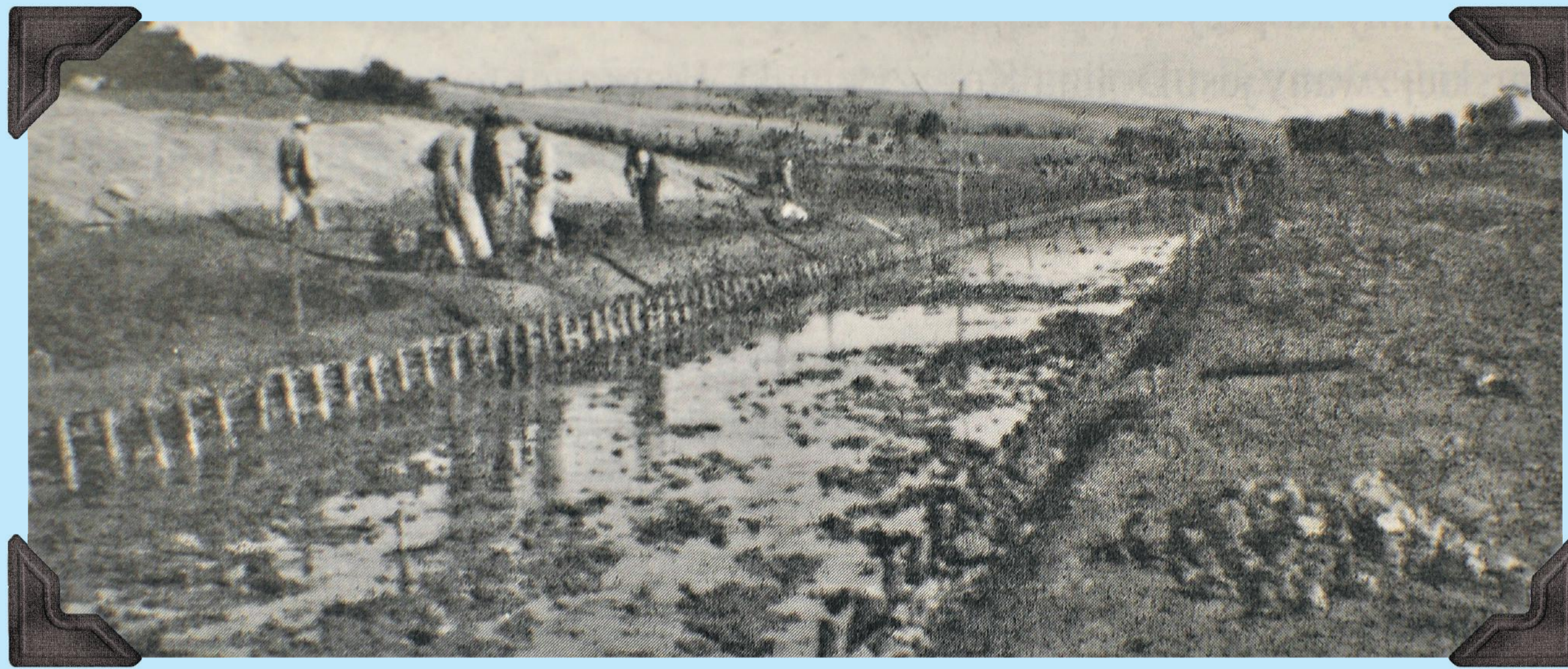
prace przy regulacji Koprzywianki, budowa nowego koryta, lata 30. XX w.; z archiwum Józefa Myjaka
